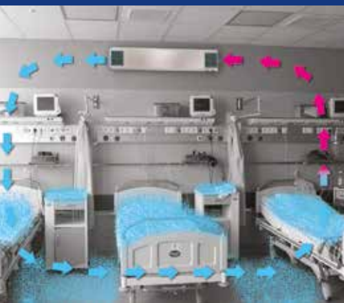
Proces oczyszczania powietrza promiennikami wewnętrznymi (powietrze)
